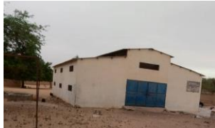
Fig.2. Entrepôt en béton dans les Niayes
