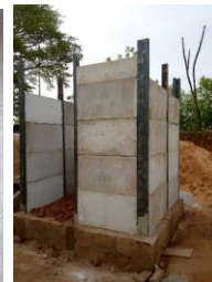
Mise en œuvre
