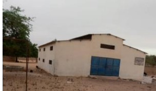
Fig.2. Entrepôt en béton dans les Niayes
