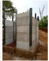
Mise en œuvre
