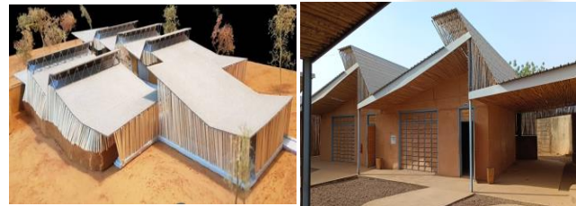
Fig4: Modèles architecturaux des bâtiments
